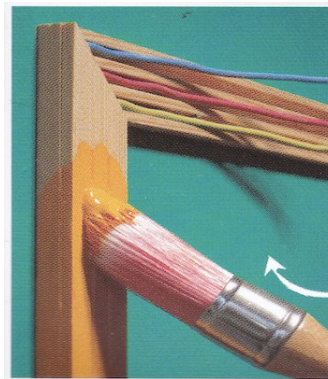
Finition peinture sur moulure bois (la norme impose un traitement du bois).
