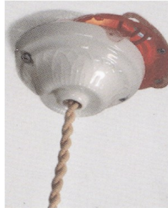
Exemple d'adaptation d'une rosace porcelaine sur un boîtier d'encastrement standard
