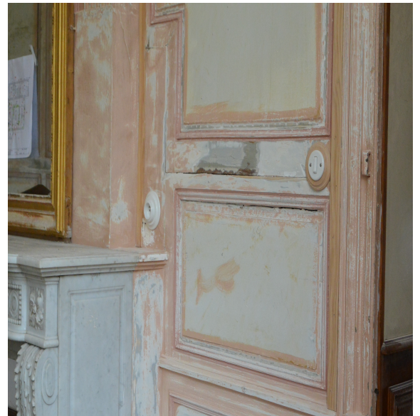
Montage électrique sous moulure bois sur les boiseries 16ème existantes
