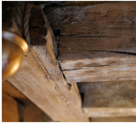
Montage fils tissés en apparent / dissimulation fil électrique avec cordelette
